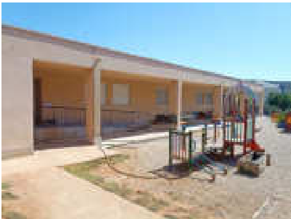
Façana Sud-Oest pati
